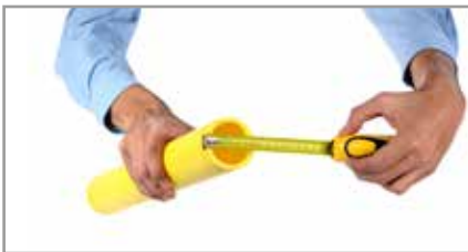
1. Medir el diámetro del tubo.
