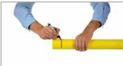
7. Marcar la profundidad de inserción del tubo.
